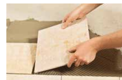
Lepljenje keramičnih ploščic
